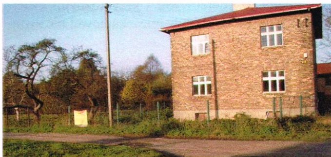
Opuszczony budynek mieszkalny w rejonie ul. Oświęcimskiej.
