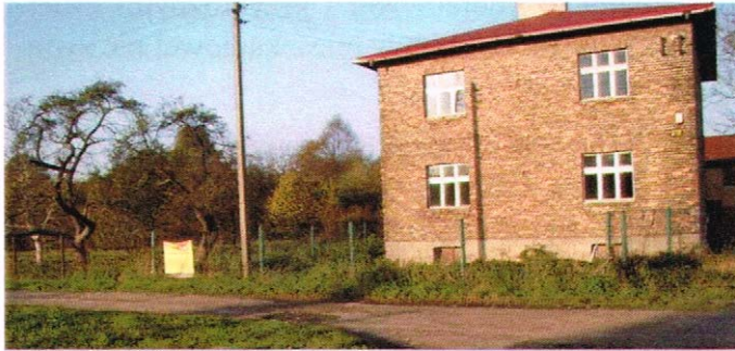
Opuszczony budynek mieszkalny w rejonie ul. Oświęcimskiej.
