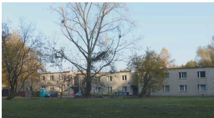
Teren istniejącej zabudowy wielorodzinnej w obszarze planu
