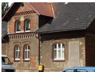
Budynek przy ul. Batorego 5
