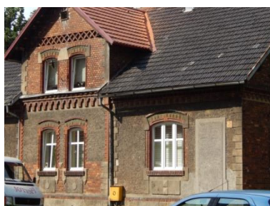
Budynek przy ul. Batorego 5
