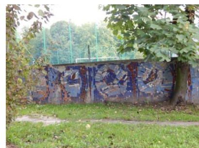
Ogrodzenie Szkoły podstawowej nr 18 przy ul. Grzegorza Fitelberga
