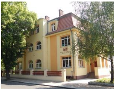
d. gminny dom mieszkalny
