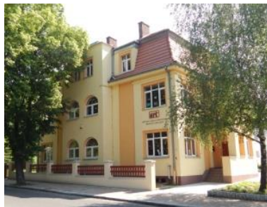
d. gminny dom mieszkalny
