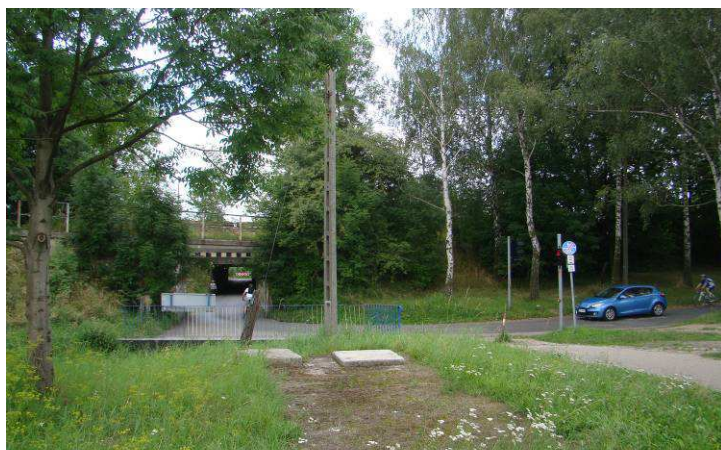
Południowo-wschodnia granica terenu, w rejonie wiaduktu kolejowego
