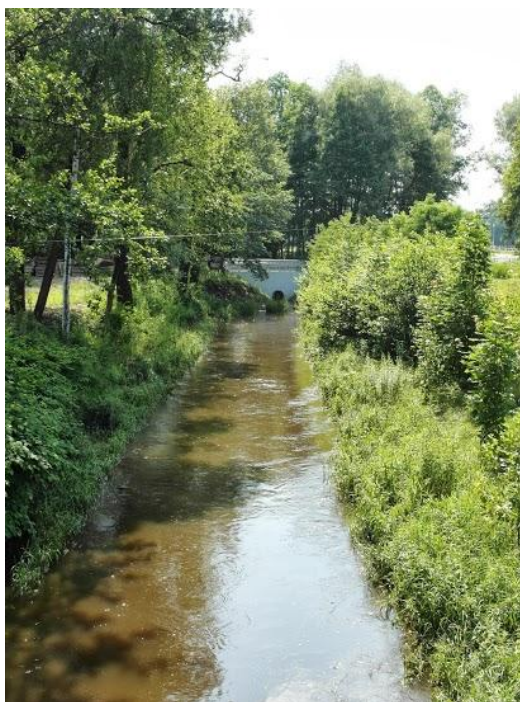
Fotografia 1 Rzeka Gostynia – widok z mostu
