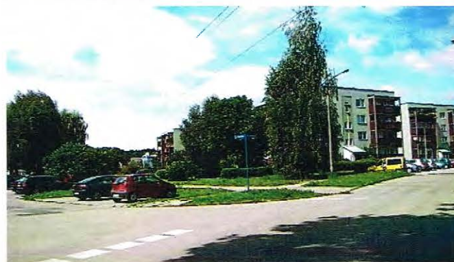
Rejon skrzyżowania ulicy Hutniczej i Wieniawskiego. Widoczna zabudowa MW od strony ulicy Hutniczej. Równolegle do ul. Wieniawskiego biegnie napowietrzna linia energetyczna - w obszarze planu.
