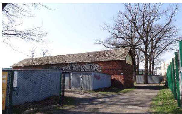
Teren 1UM – istniejące zagospodarowanie, w tle widoczne zadrzewienia które projekt planu nakazuje zachować
