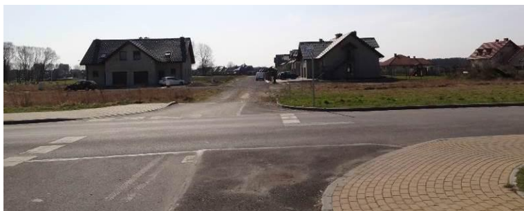
Widok na nowo budowane domy po obu stronach ulicy Szuwarków, w rejonie terenów 2MN i 3MN
