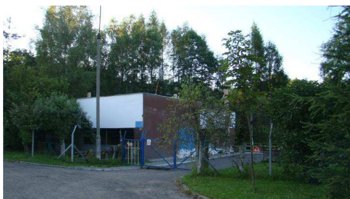
Teren 16K – przepompownia ścieków RS Żwaków
