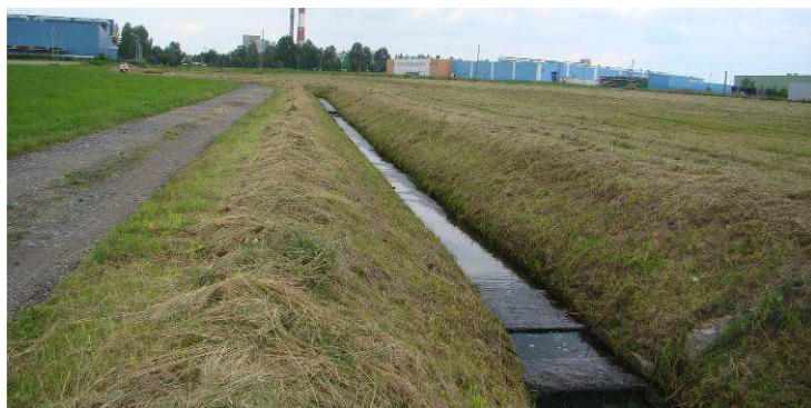
Rów melioracyjny biegnący od strony wschodniej (poza mpzp)
